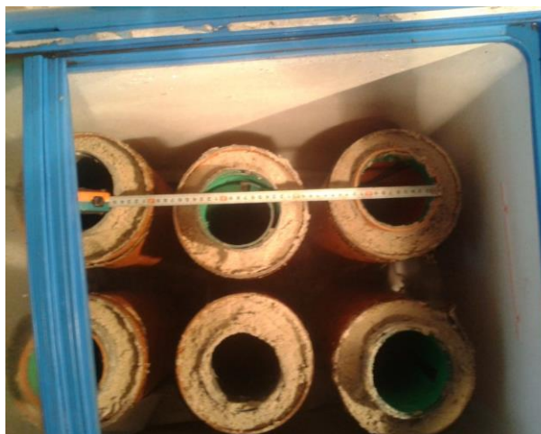
Рис. 2. Омоноличивание КГЭ фильтров в морозильном ларе
