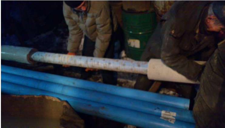
Рис. 3. Сборка криогенно-гравийного фильтра
