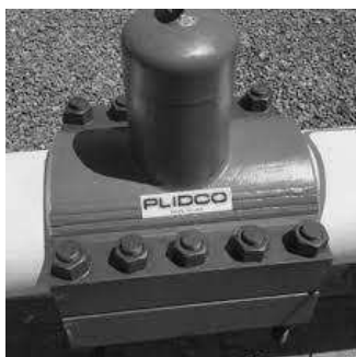
Рис. 1. Ремонтна муфта фірми «Plidco»
