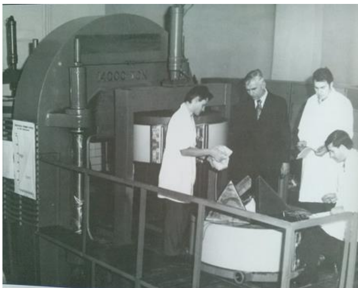
О. О. Боримський, О. Й. Пріхна, О. О. Шульженко та В. І. Житнецький проводять експеримент з використанням пресу зусиллям 14000 тон виробництва фірми ASEA (Швеція)
